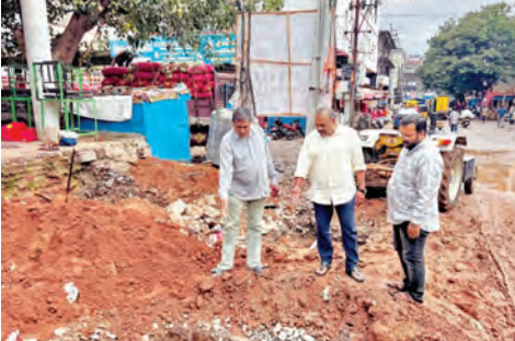
మార్కెట్ టాయిలెట్ల నిర్మాణం పనులను పరిశీలిస్తున్న ఇన్చార్జ్ ఎన్‌జిఎస్ చిలక నర్సింహరెడ్డి తదితరులు
